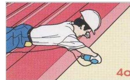
3. วางแผ่นที่ 2 ซ้อนทับกับแผ่นแรก โดยต้องวางซ้อนโดยระยะซ้อนทับ อย่างต่ำ 10 ซม.
