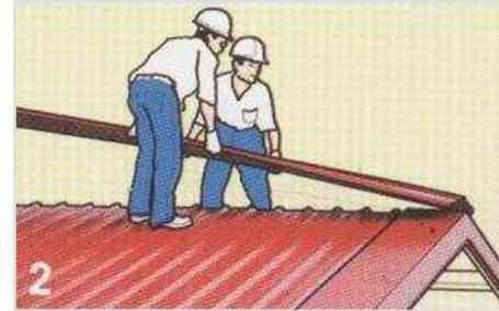
1. ถ้าต้องการพับหัวแผ่นขึ้น ให้พับหัวแผ่นหลังคาขึ้นทั้งสองด้าน ด้วยเครื่องมือหรือคีมตัดเหล็ก
