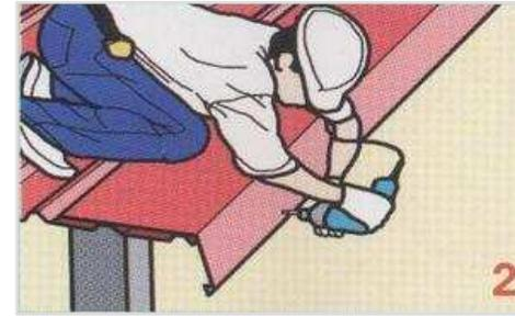
1. เริ่มติดตั้งแผ่นครอบข้างจากปลายแผ่นก่อน โดยยึดสกรูทุกระยะ 50 ซม.
