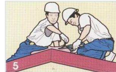
3. ใช้กรรไกรตัดเหล็ก บากด้านข้างแผ่นปิดครอบให้ได้รูปรอยตัด ตามสันลอนหลังคา
